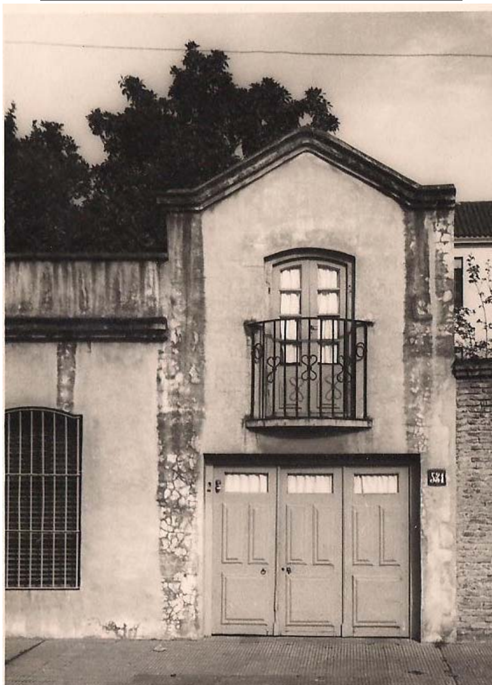
Fachada de la Casa Luis Cordiviola-Riccarda Merzbacher-Detalle.
