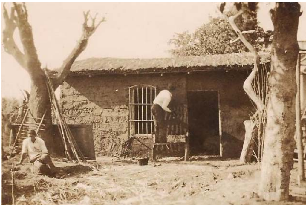
Rancho en construcción- San Isidro-Buenos Aires-Archivo particular.
