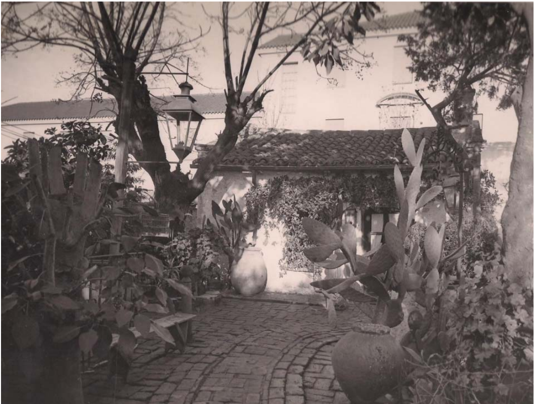
Exterior de la casa-rancho con techo de tejas musleras. Archivo particular.
